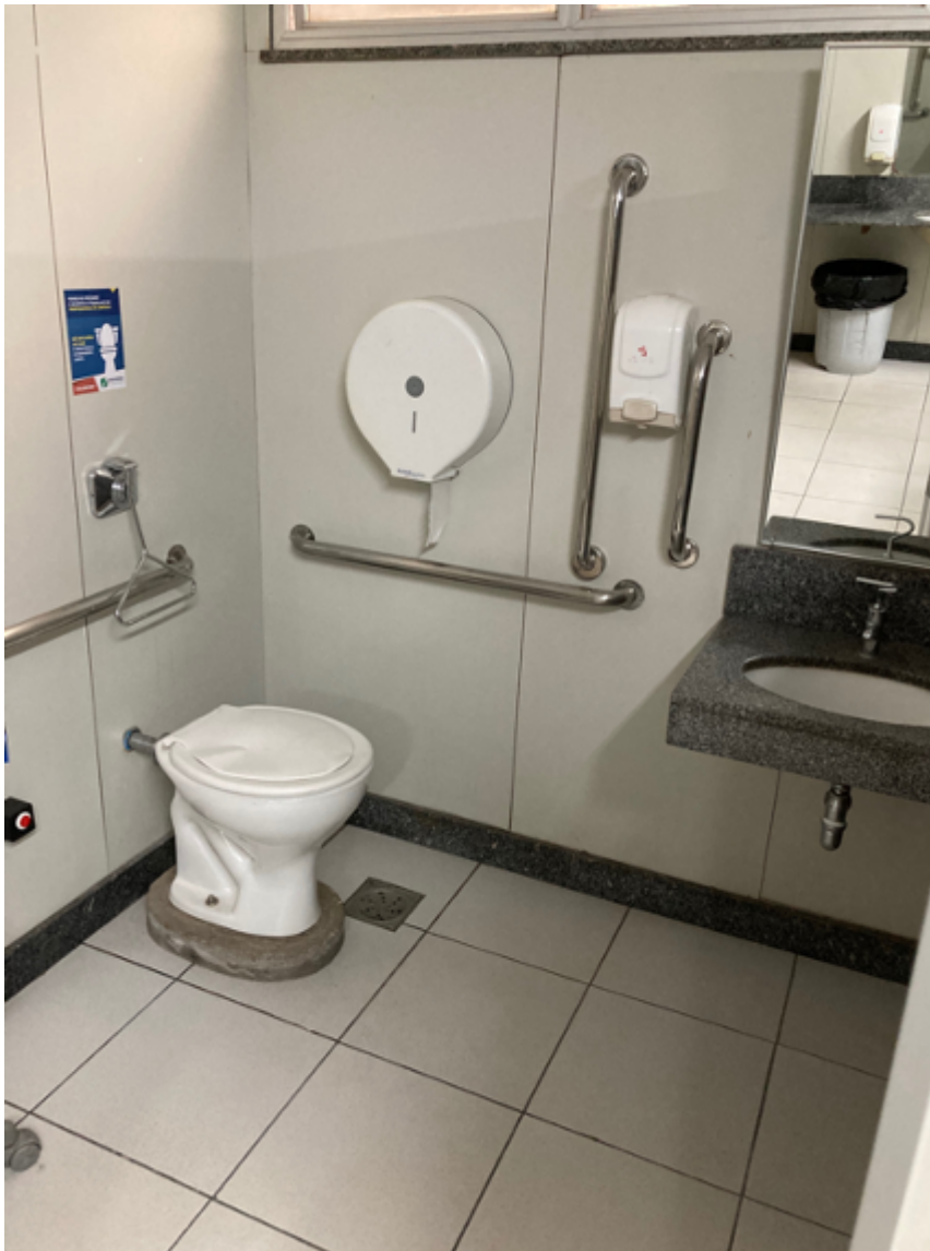
Vaso de Sanitário acessível
